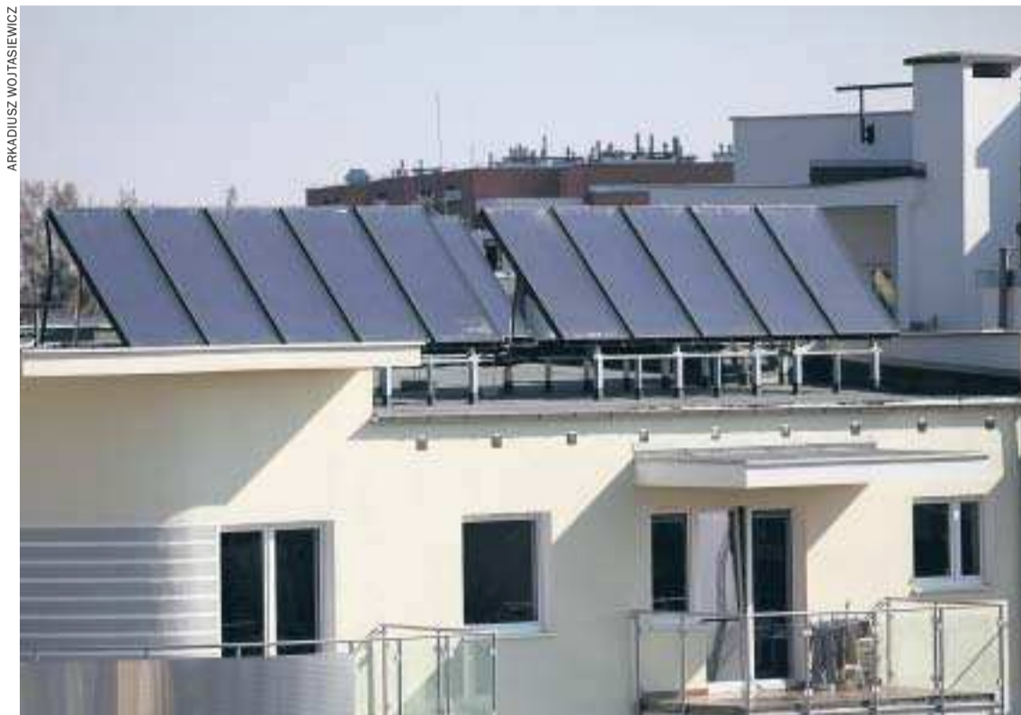
Kolektory słoneczne montuje się zwykle na dachach, ale można również postawić w ogrodzie. Sprawdzają się do ogrzewania wody użytkowej
