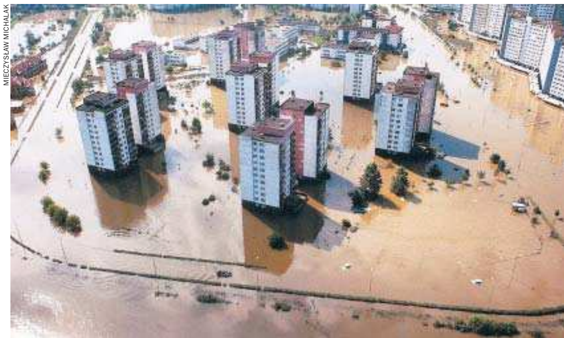
Wrocławski Kozanów został wybudowany częściowo na terenach zalewowych. W 1997 roku został całkowicie zalany
